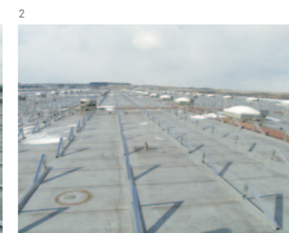
1 Il n'a pas fallu plus de dix semaines entre la conception et le raccordement au réseau de l'installation d'Emsbüren.
