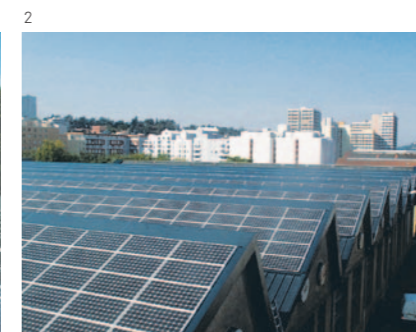
1 Installation Arthenas sur la toiture d'une exploitation agricole.
